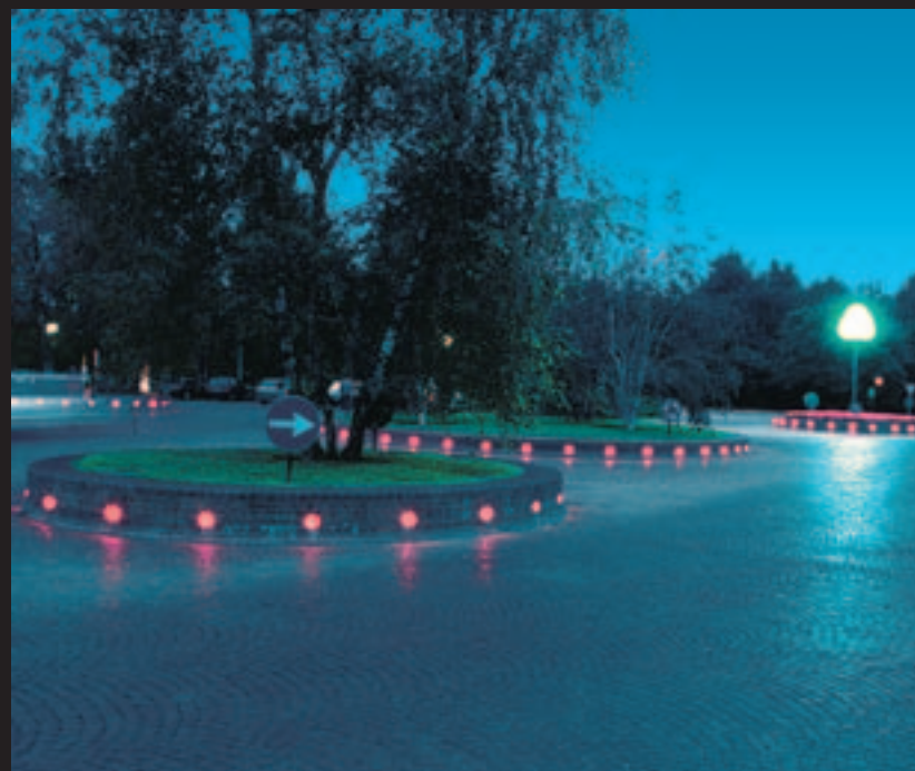
Stadtteil S. Felice, Mailand - Zufahrtsstraße - Einbau Nauto/IVELA
