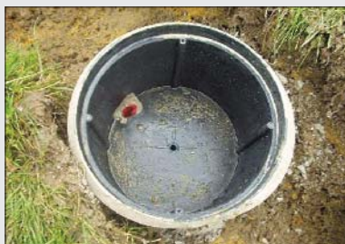
Kábelbevezetés helye (piros)
