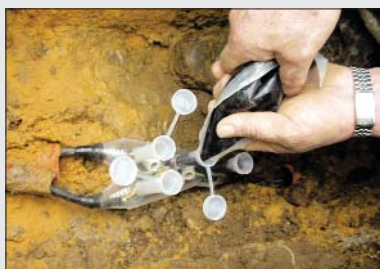
A víz alá süllyeszthető dobozt az IP 68 védelem biztosításához fekete műgyantával kell kitölteni.
