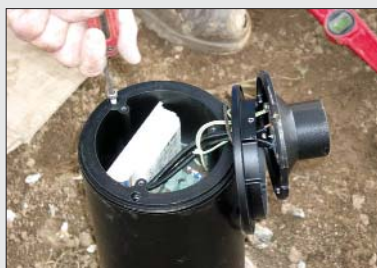
Lámpatest elhelyezése az alapozó egységre
