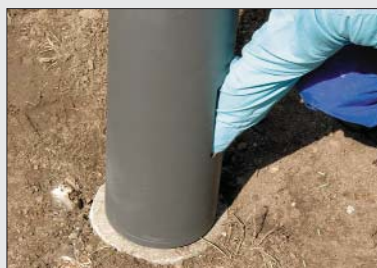
Lámpatest elhelyezése az alapozó egységre, rögzítés belülről
