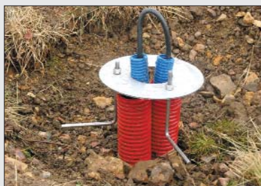
Alapozó egység besüllyesztése
