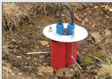
Alapozó egység besüllyesztése
