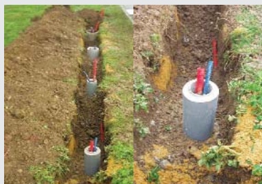
Az árokban az oszlopokat betonba kell ágyazni.
