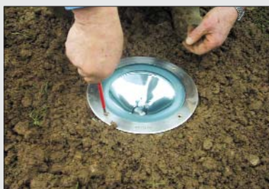
A lámpatestet a házhoz a mellékelt 4 csavar segítségével kell rögzíteni.
