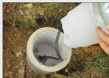
Karbantartási célból hagyjunk néhány centiméterrel hosszabb kábelt a házban.
