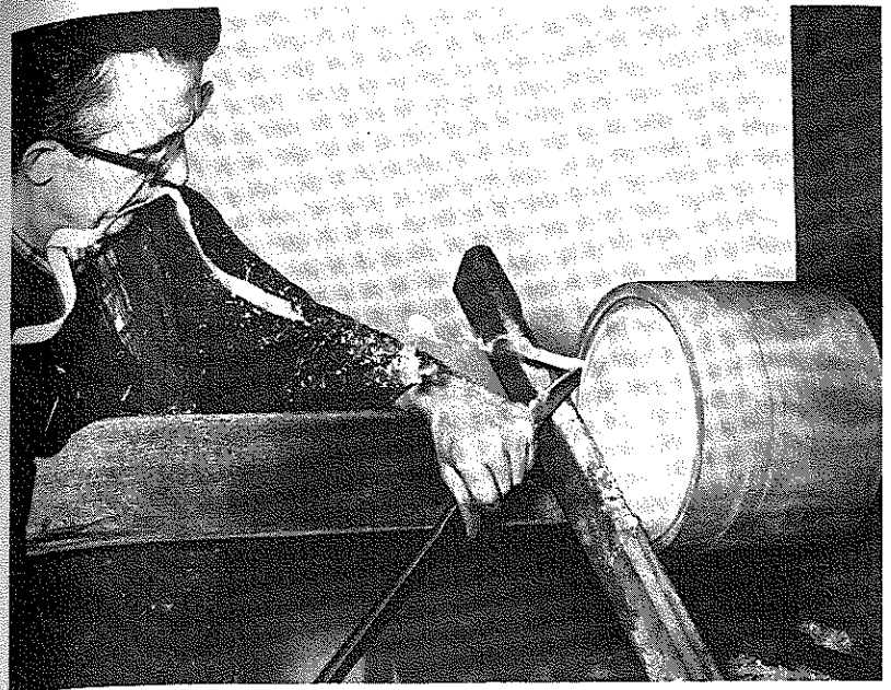
112. ábra. A láb felőli oldal esztergályozása kettős horoggal
