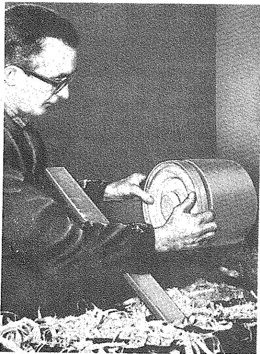
113. ábra. Az abroncs csaprahúzása
