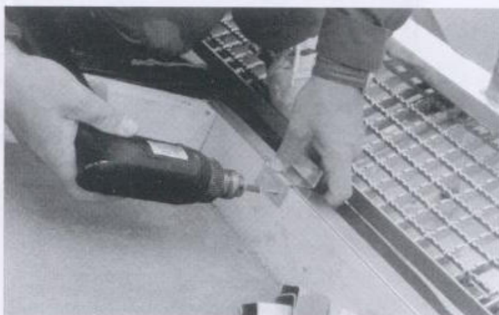
45. ábra. Az üvegtartó szögidom felszerelése
