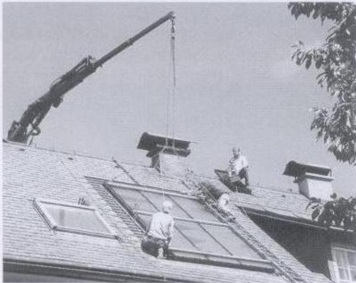
54. ábra. Egy 12 m 2 -es napkollektormezőt daruval 20 perc alatt helyére lehet tenni
