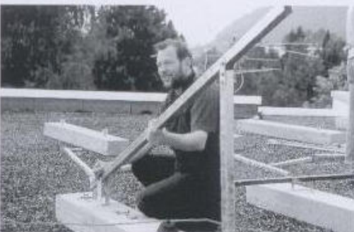
38. ábra. A kollektor felemelése az ifjúsági vendégházra, Villach
