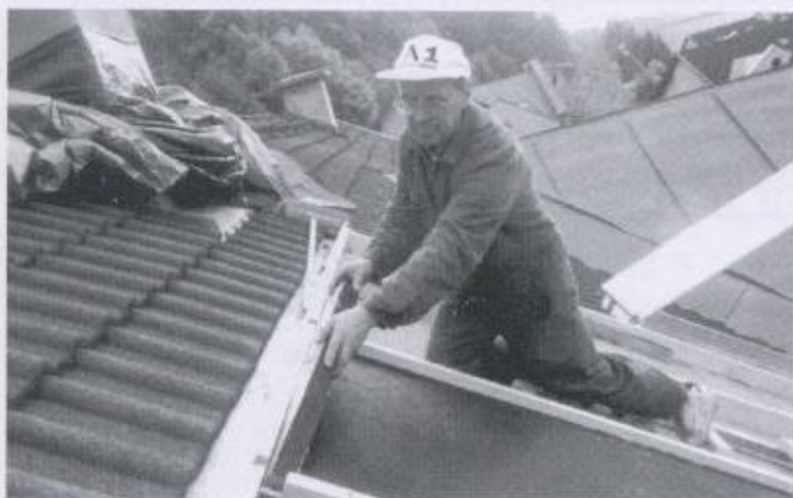
44. ábra. A kollektor-szigetelőlap berakása
