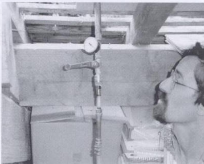
48. ábra. A kollektor kompresszoros nyomáspróbája
