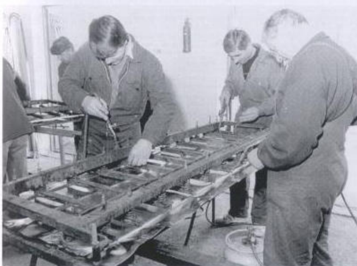
18. ábra. A K4 kollektor gyártásának fázisai
