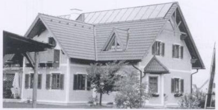
39. ábra. Tetőbe beépített napkollektorok
