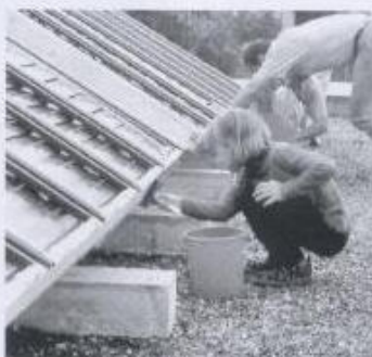
38. ábra. A kollektor felemelése az ifjúsági vendégházra, Villach
