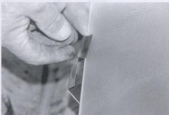
51. ábra. Az üveglap élére húzzunk rá egy darab üvegtartó gumit, hogy az üveg élét az üvegtartó szögidombban megvédje
