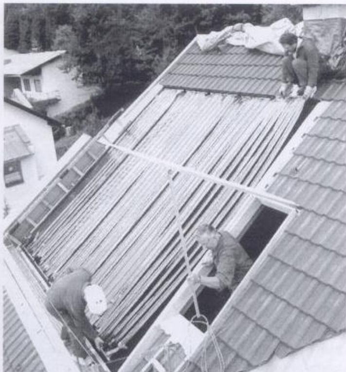
47. ábra. Az abszorbermező behelyezése
