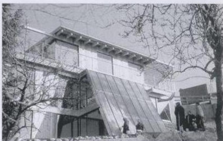
15. ábra. Napenergiával támogatott kiegészítő fűtés. Walder/Klammer-féle létesítmény (Villach)
