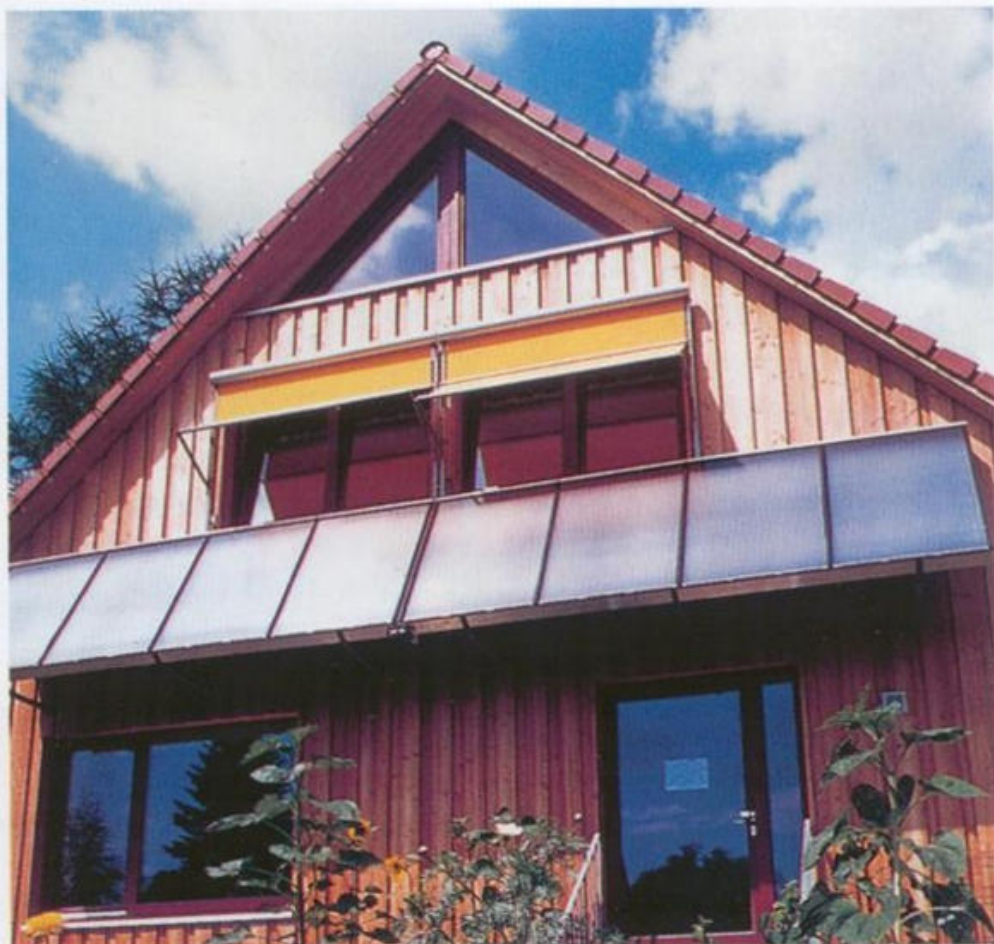
Erkélyre felszerelt kollektorok
