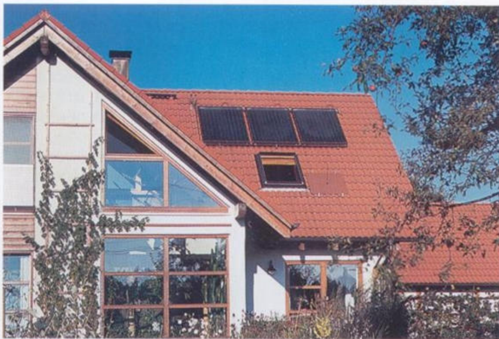
Fontos a napkollektoros berendezés igényeknek megfelelő méretezése
