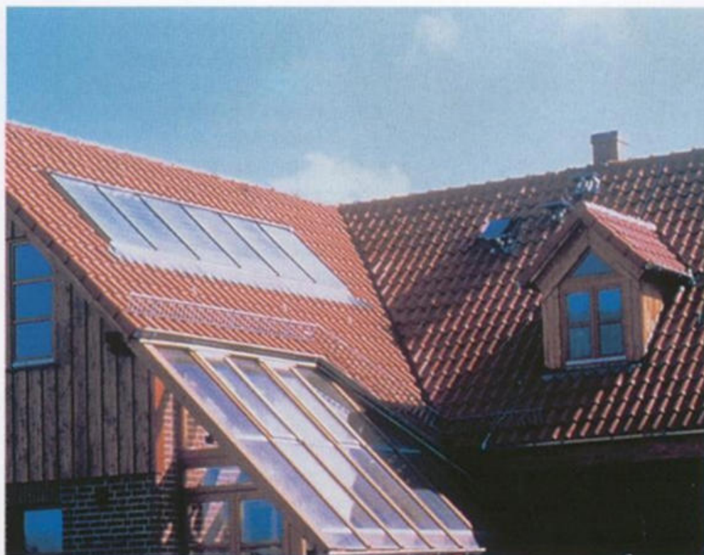
Kollektorfelületek esztétikus beépítése
