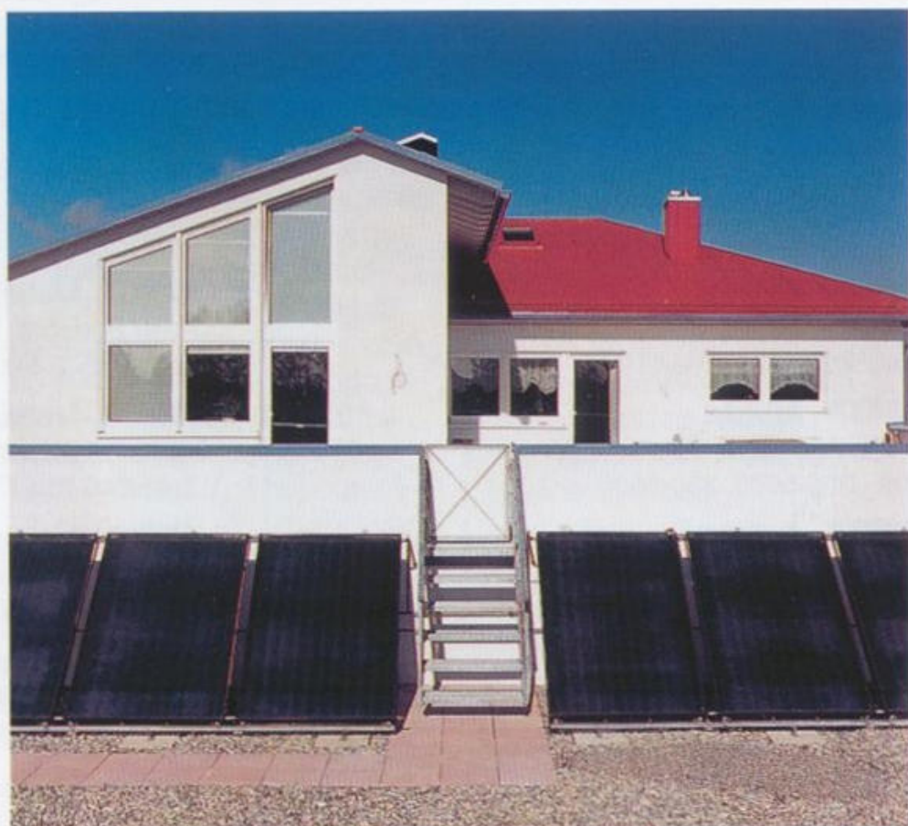
Erkélyre felszerelt kollektorok
